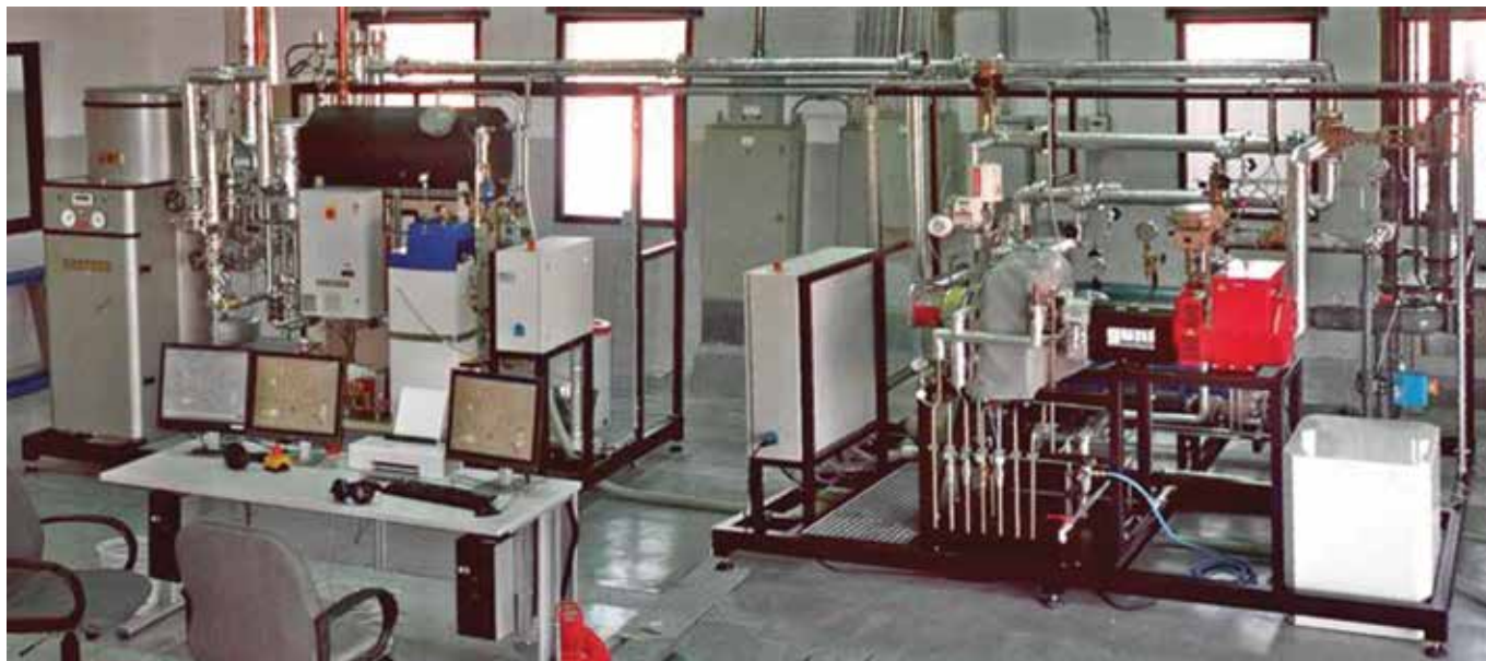
Электростанция в сборе: парогенератор (слева), паровая турбина (справа), станция управления (спереди)
