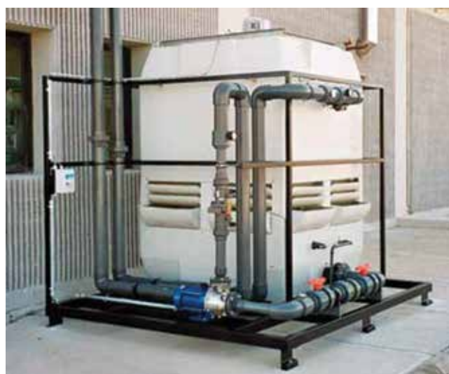
Градирня с насосом водяного охлаждения
