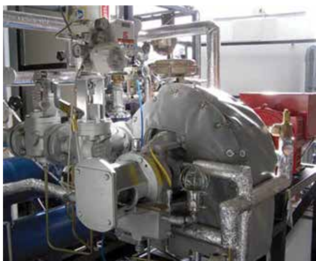
Паровая турбина с дроссельным клапаном и генератором
